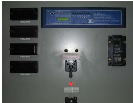
Figure 4—O Relé SEL-300G (mostrado acima instalado), o primeiro com tecnologia de microprocessadores para atender às normas de proteção de turbinas do IEEE, incorpora diversos recursos exclusivos projetados para fornecer sistemas inigualáveis de proteção, monitoração e controle de geradores elétricos nas aplicações de concessionárias e indústrias.
