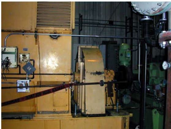
Figure 2—Com o objetivo de tornar a transformação altamente eficiente sob o ponto de vista econômico, Barlow optou por incorporar uma turbina geradora usada que foi adquirida de uma concessionária localizada nas Bermudas.
